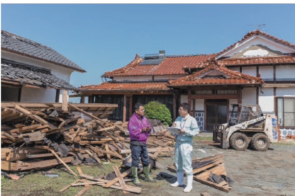
自然災害時の損害調査の様子
